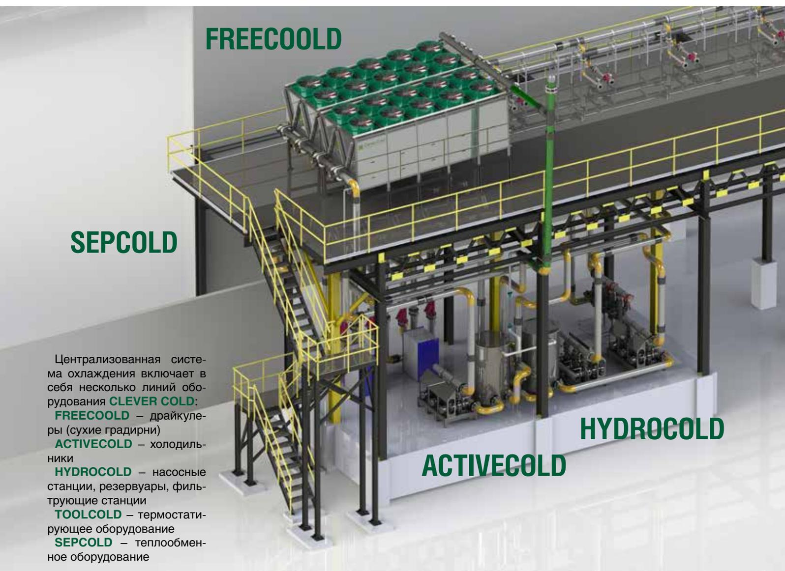
Централизованная система охлаждения включает в себя несколько линий оборудования **CLEVER COLD**:
